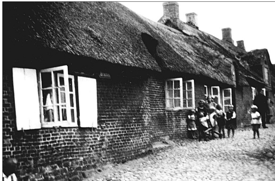
Bracken in Rödemis: Straße und Gebäude erinnern an die frühere Kasernenanlage. Aufn. um 1900
