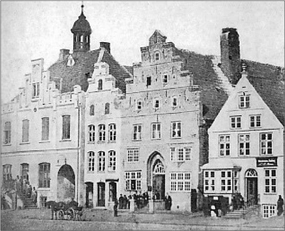
Abb. 1: Ansicht des Alten Rathauses (Fassade von 1858) sowie der östlich anschließenden Häuser Markt 1,3 (Herrenhaus) und 5, um 1870.
