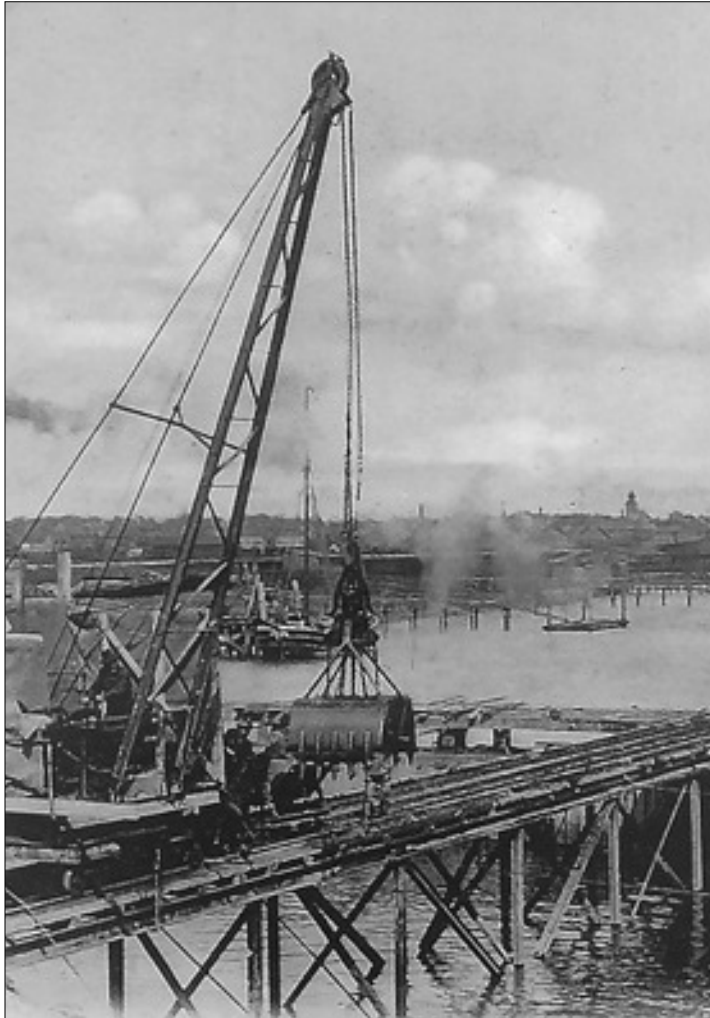
1902 wurden die Arbeiten an der neuen (zweiten) Seeschleuse begonnen
