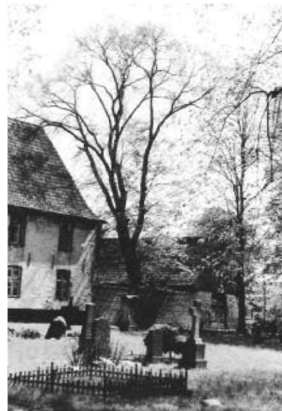
Abb. 3: Der Südteil des Klostergebäudes und der alte Klosterstall. Blick von Westen über den St.-Jürgen-Friedhof. Fotografie von Walther Nehm, 1957 (Gasthausarchiv).
