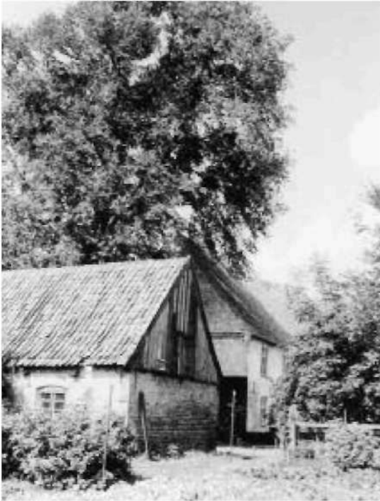
Abb. 4: Der Klosterstall (Ostgiebel), dahinter der Südteil des Klostergebäudes (Gasthausarchiv).
