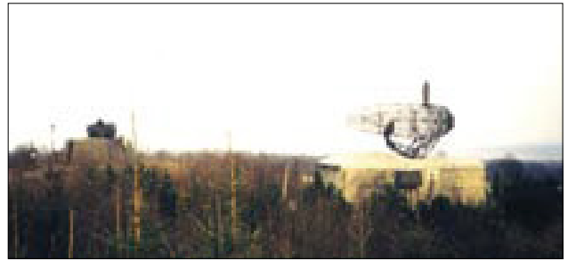
Stellung Hude (1986). Im Vordergrund das Rundumsuchgerät IPAR (AB/MPQ 50) mit der Gitterantenne und der aufgesetzten Antenne gegen Störmaßnahmen. Im Hintergrund das Hochleistungsradargerät IHPI (AN/MPQ 46) mit den beiden Antennen (Sendeanenne rechts, Empfangsantenne links). Die unteren Teile des Geräts werden durch einen Shelter geschützt. Auch über die Antenne konnte eine Kuppel geklappt werden, dann war aber kein Sendebetrieb möglich. Diese Stellungen bestehen teilweise auch heute noch und werden für Übungen genutzt.
