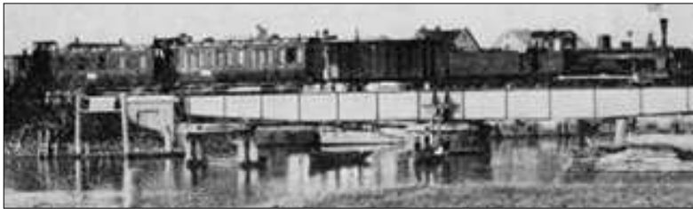
Eingleisige Drehbrücke über den Husumer Hafen, 1887. Länge 34 m.
