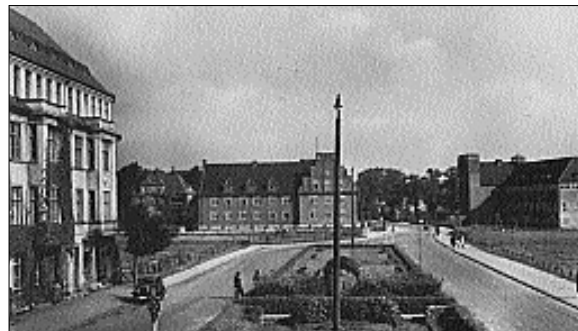
Der Blick zeigt vom Bahnhof aus nach Norden. Links ein 1911 gebautes Doppelhaus, rechts davon der frühere Arzt Spethmann, 1912/13 als Eisenbahnbetriebsamt gebaut, dann Finanzamt (Bildmitte) und das Nissenhaus (1936/37).
