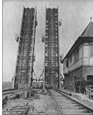
Die eingleisige Drehbrücke wurde 1910 durch eine zweigleisige Klappbrücke ersetzt. Ein Brückenteil wurde 1963 ausgebaut. (Aufn. ca. 1910)
