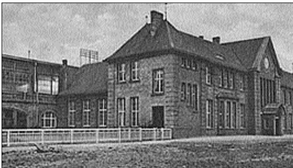
Der Neubau des Bahnhofs in der Poggenburgstraße begann 1910. Im Jahre 1912 wurde er in Betrieb genommen. Die Poggenburg- und die Herzog-Adolf-Straße entstanden. Der Bahnhof wurde 1986 unter Denkmalschutz gestellt.
