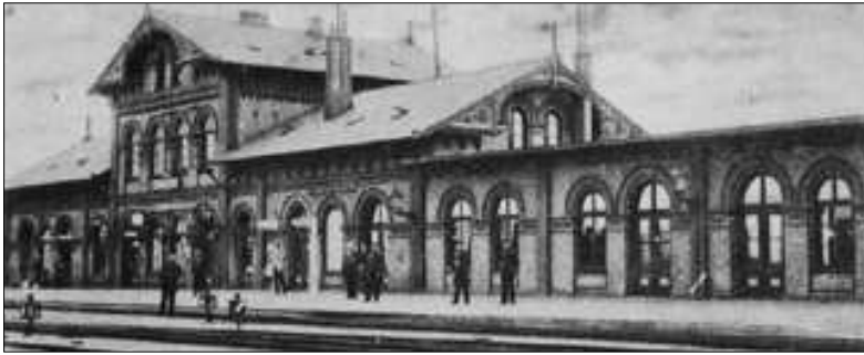
Der Bahnhof der Marschbahn hatte einst große Bedeutung, diente zuletzt aber nur noch als Verwaltungsgebäude.
